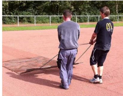
fahren auf dem Aschenplatz im Sportpark. Dabei wurde der Platz mit einem Schleppnetz wiederholt abgefahren und die größeren, bei Stürzen gefährlichen Lavasteine aus dem Platzunterbau aufgesammelt. Rund 250 der abgebildeten Häufchen wurden gebildet und wurden anschließend mit Schippe und Eimer manuell aufgesammelt.
